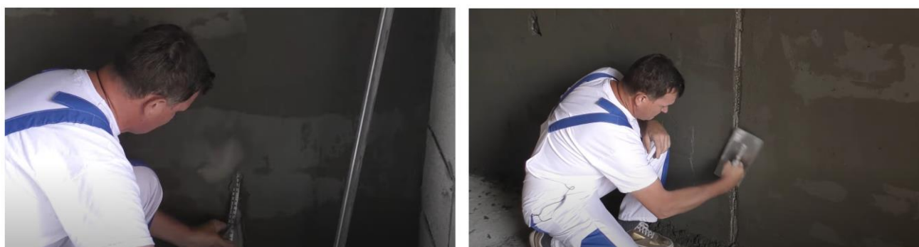
Рис. 27. Схема демонтажа маяков и заделки образовавшихся борозд
